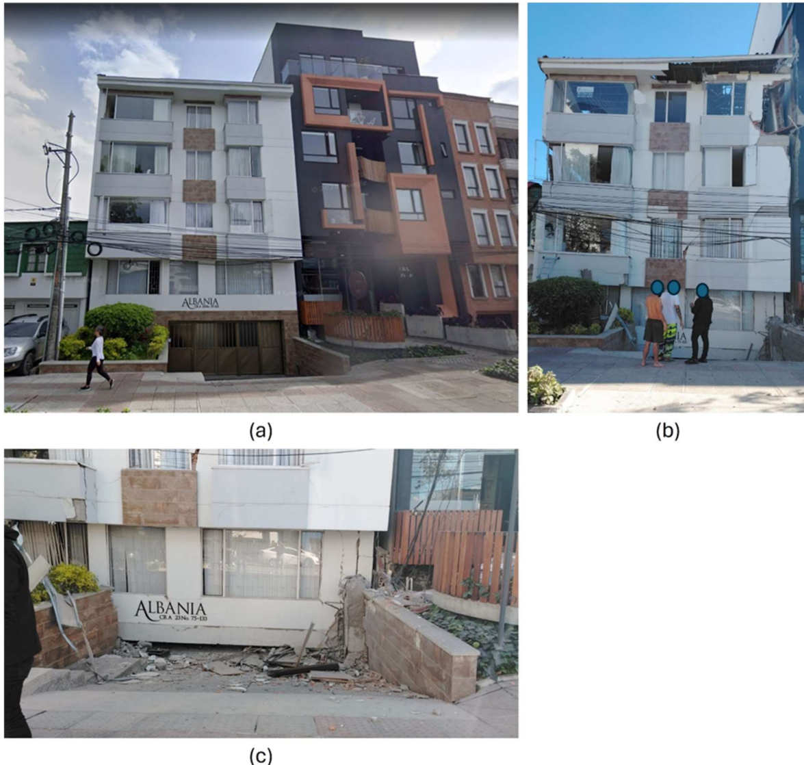
Figura 3.2. Colapso de primer piso en edificio ubicado en la ciudad de Manizales (a) Foto antes del sismo (Google Maps, 2026a), (b) & (c) Fotos después del sismo mostrando el colapso parcial de la estructura (Fuente: fotografías proporcionadas por Juan Ocampo, vía WhatsApp).
